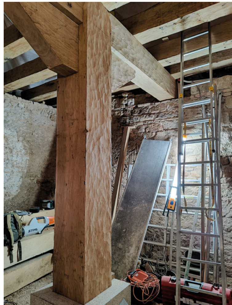
Opravy na Karlštejně Repairs in Karlštejn Castle
