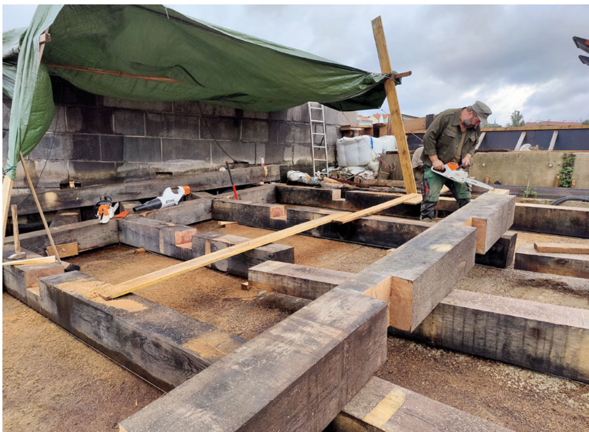
Dubový rošt pláště Staroměstského jezu The oak grate of the Old Town Weir casing.
