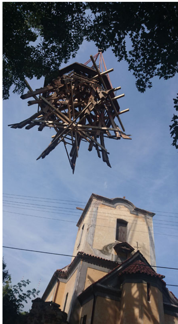
Spouštění celého krovu věže v Bilanech Lowering the entire roof frame of the tower in Bilany.
