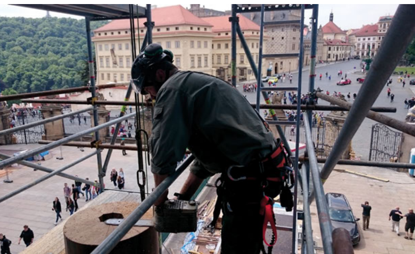
Odstraňování poškozených sloupů na prvním nádvoří Pražského hradu Removal of damaged columns in the first courtyard of Prague Castle.
